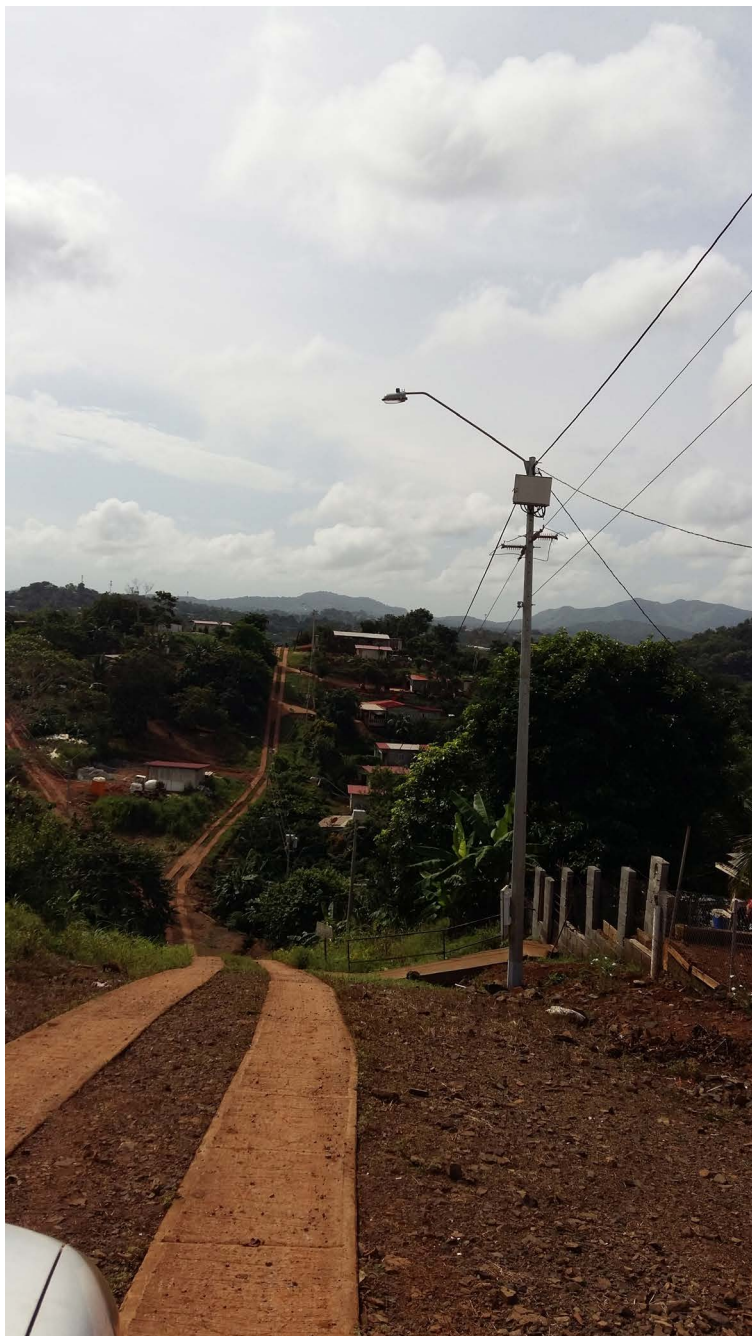
Instalación del sistema prepago y red blindada en comunidad La Alameda en el corregimiento de Burunga en Zona Panamá Oeste.
