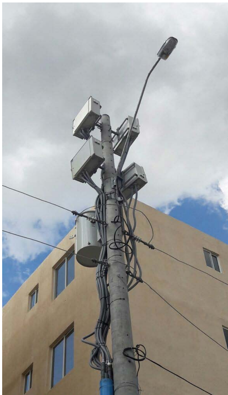
Instalación del sistema prepago en edificio remodelado de área roja de Zona Panamá Metro
